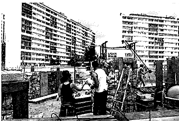
Chantier, Plateau d'été, 2012
